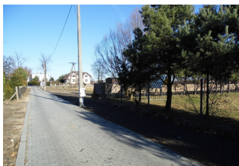
Zakończono budowę ul. Słonecznej w gminie.
